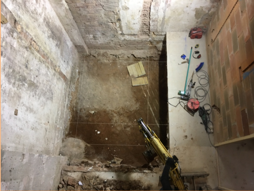
Foto 9. Vista general del lloc un cop realitzades les tasques d'excavació.
