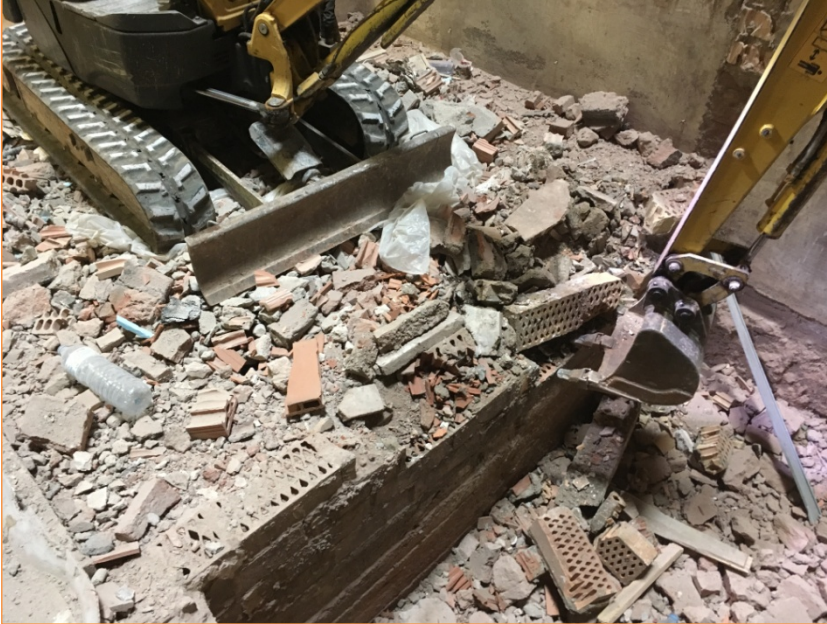
Foto 3. Inici dels treballs d'excavació.
