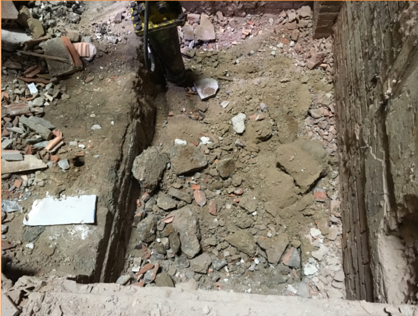
Foto 5. Treballs d'enderroc de la solera de l'antic ascensor UE 4.
