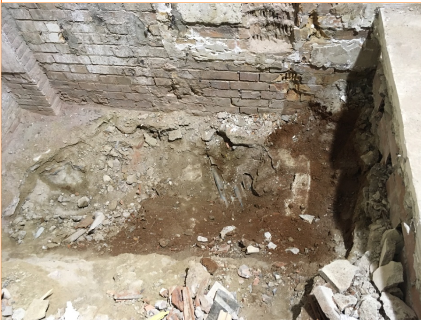
Foto 6. Treballs de descobriment dels cables elèctrics UE 5.
