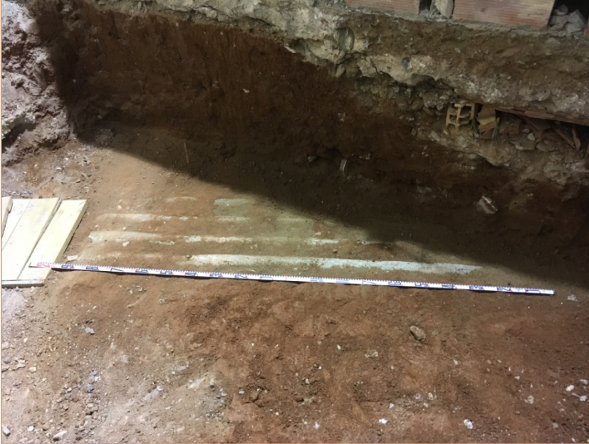
Foto 7. Estat final dels cables elèctrics UE 5.
