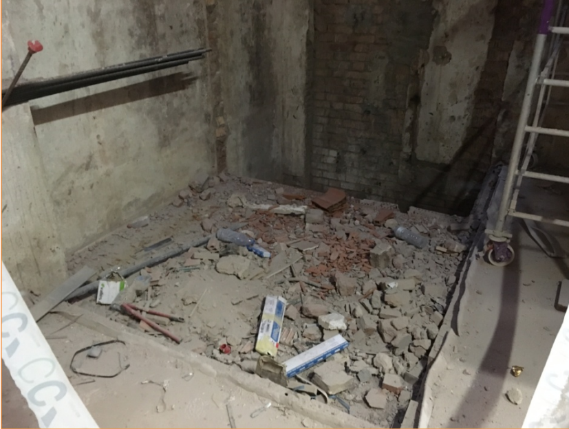
Foto 1. Estat inicial del lloc on s'ha d'instal·lar l'ascensor.
