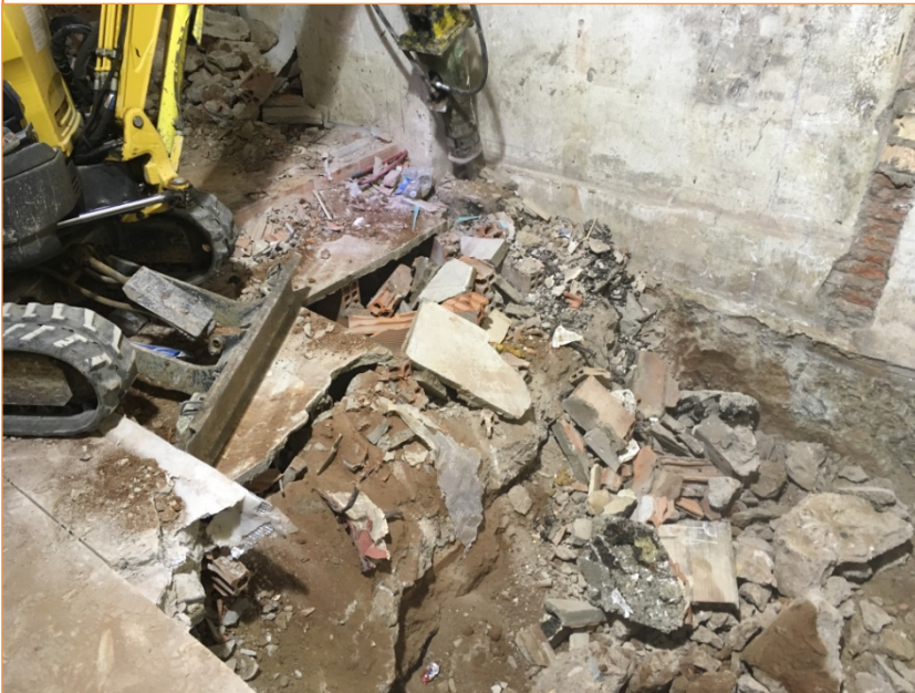
Foto 4. Treballs d'enderroc dels paviments UE 1 i UE 2.
