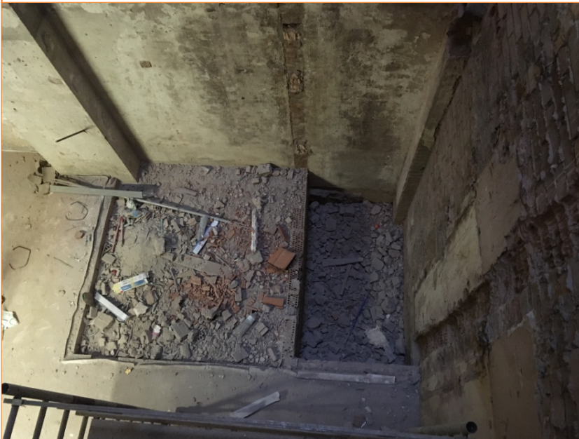
Foto 2. Vista general del lloc on s'ha d'instal·lar l'ascensor.
